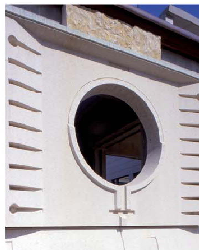
Thermes Chevalley, 2000. Détail d'un oculus, béton moulé et pierre
