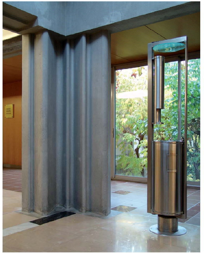
Thermes Chevalley, 2000. Pilier en béton plissé
