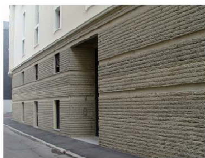
Immeuble, le Lutécia , 7-9 rue de la Chaudanne, 2007. Béton taillé façon pierre de taille
